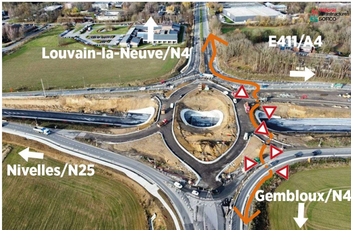
Pendant cette dernière phase, les travaux se poursuivront globalement **au nord de toute la zone du chantier** (carrefour en diamant, pont surplombant l'autoroute, aménagements cyclables, parking de covoiturage). Les feux qui équiperont le carrefour en diamant doivent être installés en mai prochain.
