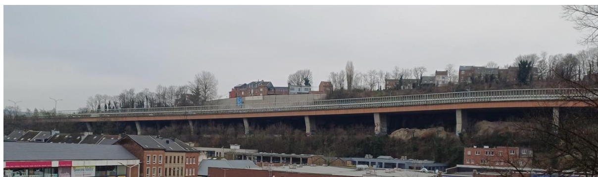
Une partie du viaduc de Lambermont
