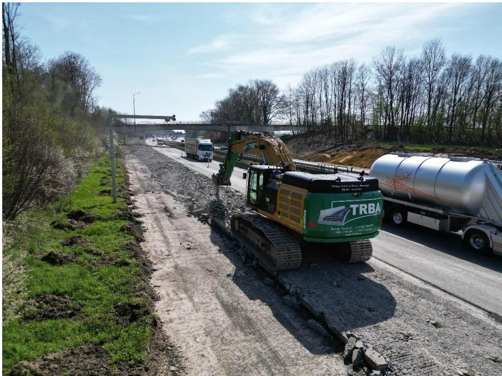
Les travaux, qui ont débuté le 20 mars dernier, visent à **réhabiliter en profondeur toute la largeur de l'E411/A4** (bande d'arrêt d'urgence, 3 voies de circulation et berme centrale) :
