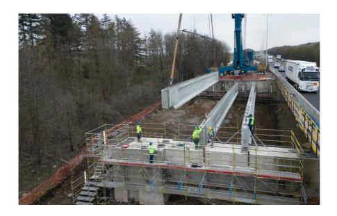
Pour l'ensemble du viaduc, avant les opérations de poses des poutres, **8700 m²** de tablier ont dû être sciés, démolis et évacués pour un total de 3900 tonnes.
