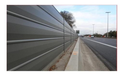
Au total, ce sont près de 5000m² d'écran antibruit qui vont être installés (contre 3500m² avant travaux) afin de réduire durablement les nuisances sonores en provenance de l'autoroute. 369 colonnes ont dû être installées pour supporter les structures.
