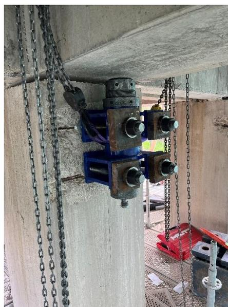
Dans le courant de la semaine prochaine, des socles en béton armé continu seront coulés et des appuis définitifs seront installés afin de soutenir définitivement le pont et pouvoir retirer les supports provisoires. Les zones d'approche du pont devront faire l'objet d'adaptation.
