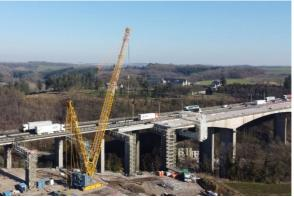
Afin de répondre aux sollicitations sans cesse grandissante des ouvrages vu l'augmentation du poids des véhicules autorisés à circuler sur nos autoroutes, une mise à niveau de la capacité portante du viaduc central a été opérée. Pour chacun des 2 viaducs, 6 câbles de précontrainte ont été ajouté. On a tiré sur chacun de ces câbles avec 360 tonnes, ce qui représente 2160 tonnes de précontrainte supplémentaire par pont.
